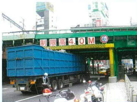
二葉橋ガード 外堀通り
