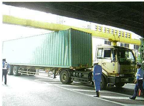
呉服橋ガード 国道1号永代通り
