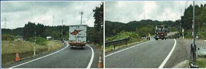
仮設道路の片側交互通行状況（小矢部市内山内内）
